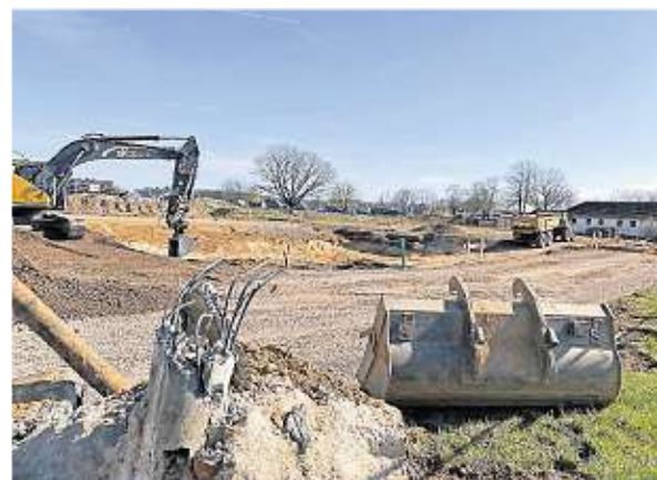
Eine große Baustelle, vom Aldi-Markt gegenüber betrachtet. Rechts im Bild das Jugendheim Astra, im Hintergrund Häuser des Neubaugebiets Neu-See-Land. FOTO: SETTNIK
