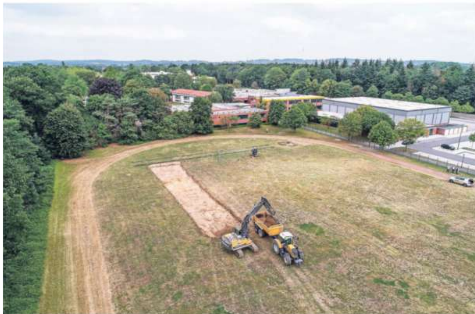
Hier entsteht auf 3500 Quadratmeter Fläche die Halle für die neuen Innungs-Werkstätten.
