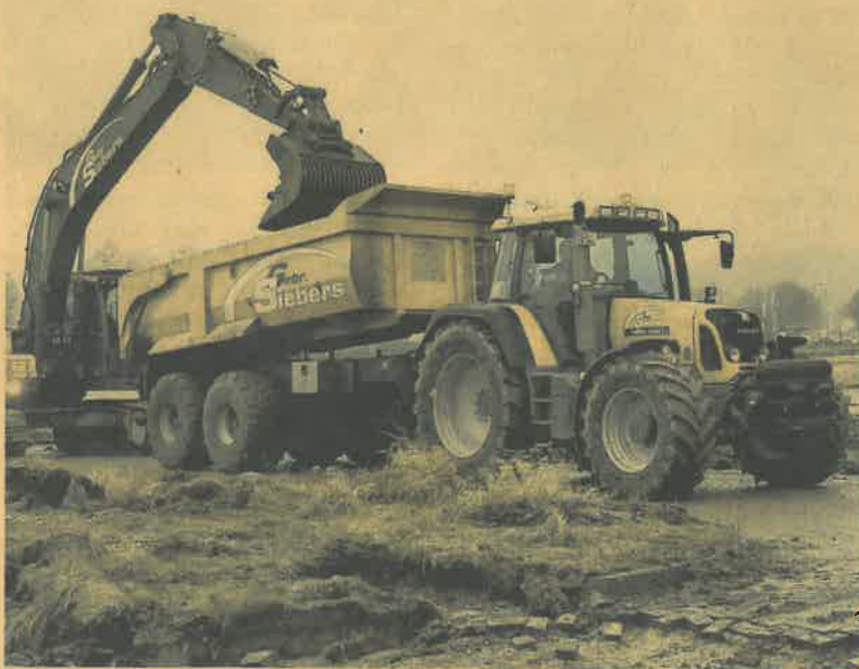
Bagger sind derzeit am Klever Ring eifrig dabei, die riesige Fläche in unmittelbarer Nähe des Hotel Cleve gegenüber der Flutstraße zu ebnen.
