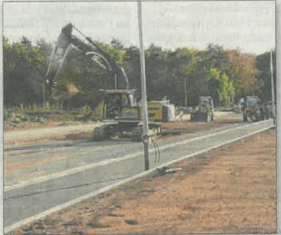
Auch die Zuwegung wurde bereits in Angriff genommen.
