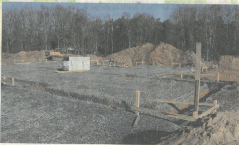
Die Baustelle der neuen Kita: Wo die einzelnen Gruppenräume entstehen, lässt sich bereits erkennen. Bis Sommer soll alles fertig sein.
