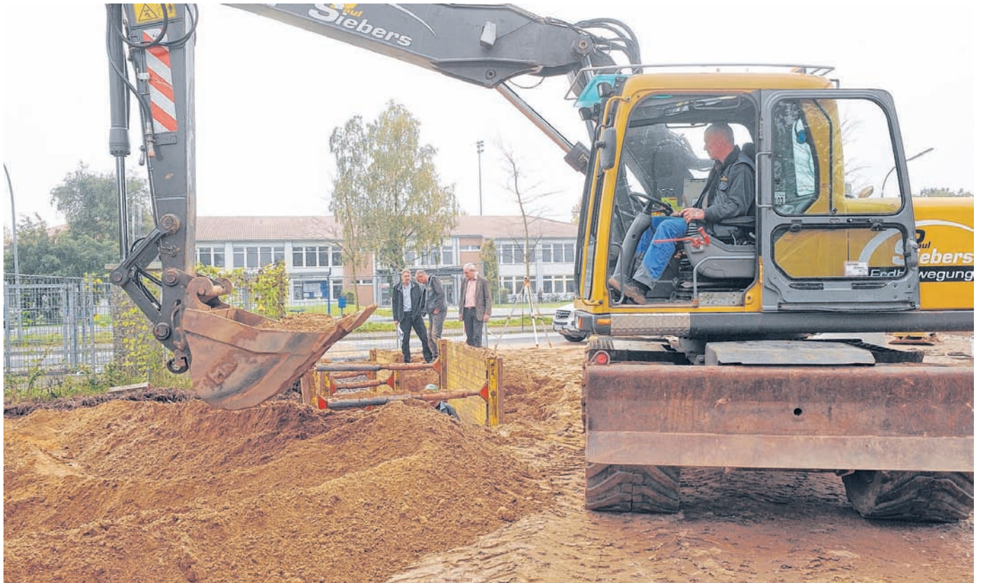
Hinten das Gymnasium – vorn der Bagger: Erschließungs-Arbeiten an der Hubert-Houben-Straße.
