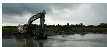
Baggerarbeiten an der Blänke
