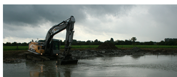
Baggerarbeiten an der Blänke
